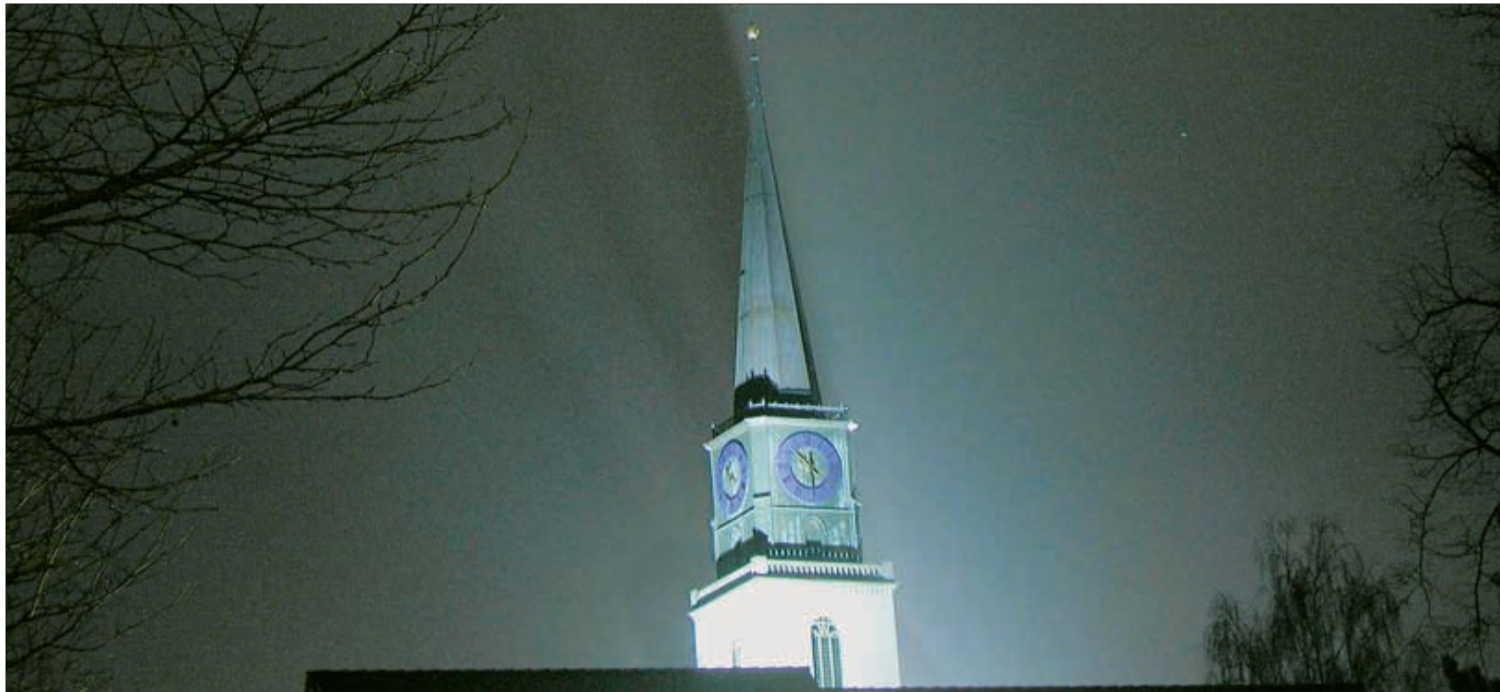
Die reformierte Kirche in Bülach wird nachts von unten her von Scheinwerfern angestrahlt. Fast die Hälfte des Lichts schiesst am Turm vorbei.
