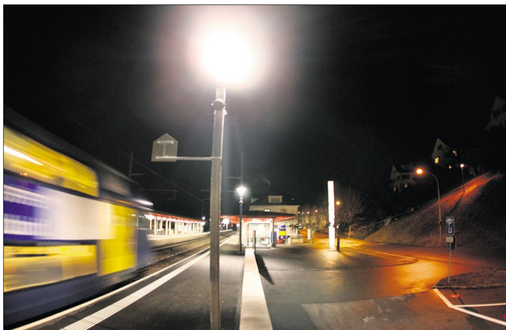
Die neue Beleuchtung am Bahnhof Oberrieden See ist problematisch: Sie leuchtet den Anwohnern direkt ins Schlafzimmer. (André Springer)
