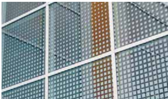
Nach oben abnehmende Rasterung: macht Sinn, wenn keine haushohen Bäume vorhanden sind.
