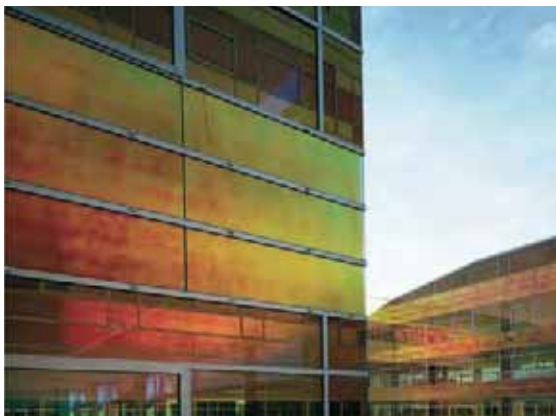
Das stark eingefärbte, reflektionsarme Glas und die nicht-transparenten Ecken machen das Gebäude vogelfreundlich.
