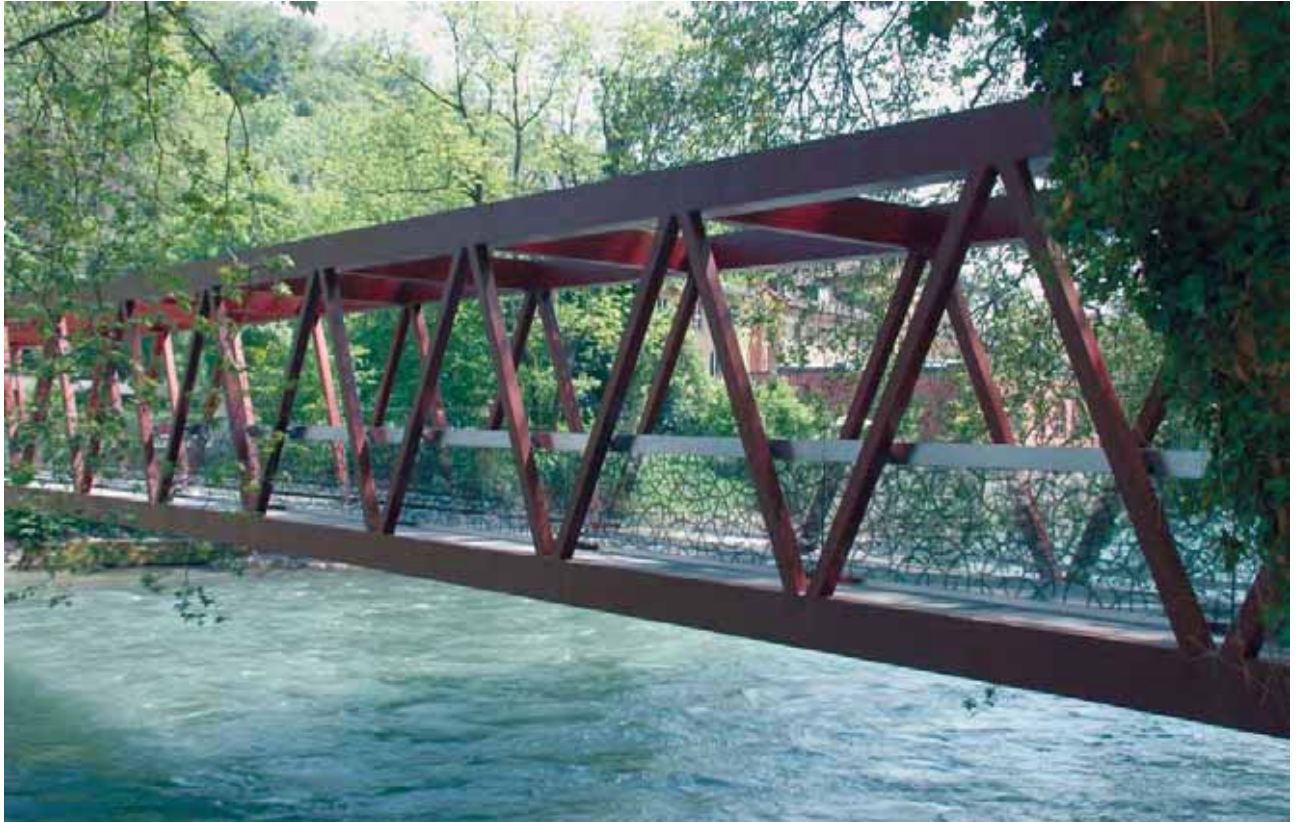
Brücken wie diese relativ knapp über den Fluss führende stehen senkrecht zur Flugrichtung der meisten Vögel. Den Anliegen des Vogelschutzes wurde schon in der Planungsphase Rechnung getragen.
