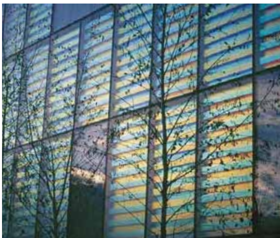
Lichtreflektierende Folienstreifen zwischen den Gläsern als dekoratives Element.
