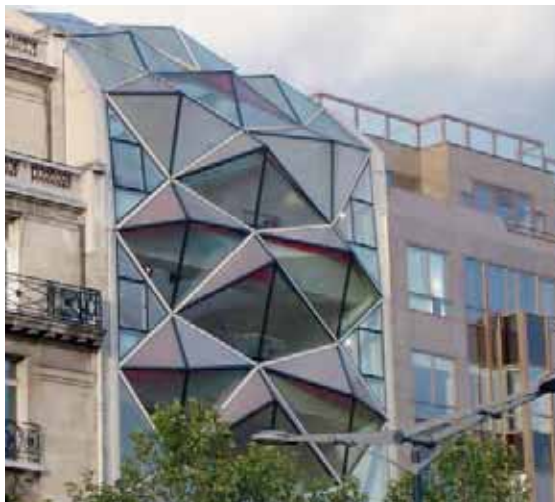
Wirkungsvolle Neuinterpretation einer Glasfassade.
