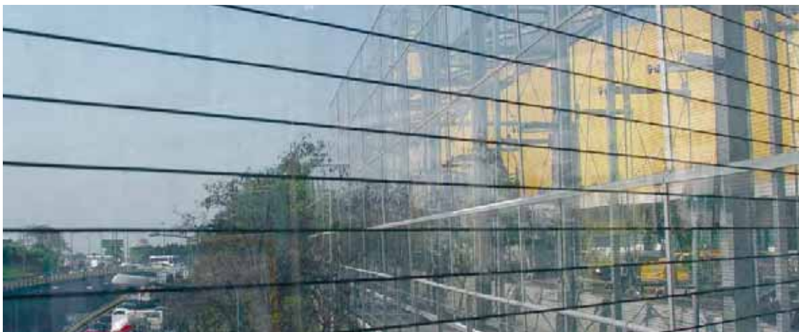
Schwarze, horizontale Linien von 2 mm Breite und einem Lichtmass von 28 mm schnitten in Laborversuchen wider Erwarten sehr gut ab. Wo es auf möglichst ungetrübte Durchsicht ankommt, könnte das eine gute Lösung sein.
