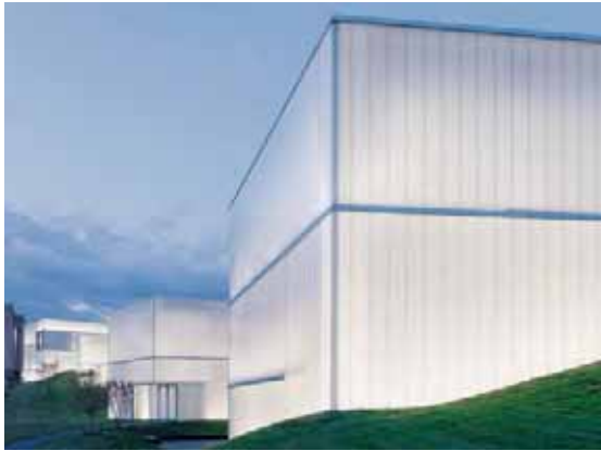
Lichtstreuende OKAPANE-Isolierplatten in doppelschaligem U-Profilglas machen Tageslicht nutzbar und reduzieren Wärmeverluste erheblich. Sie sorgen für eine optimale gleichmässige Lichtabgabe in den Raum.
