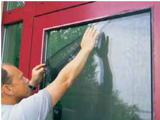
Das aussen seitige Anbringen eines Insektenschutzgitters reduziert die Spiegelungen stark.
