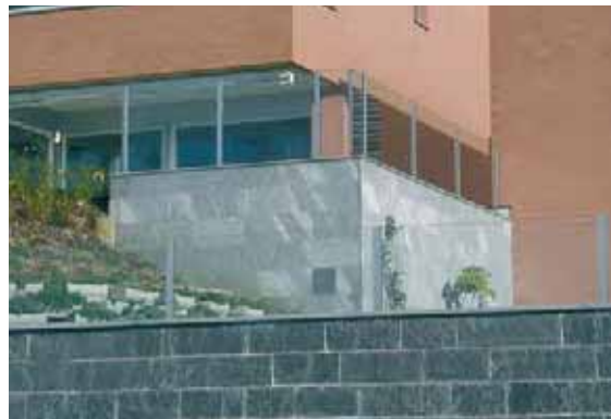
Balkonverglasung und Lärmschutzwand
