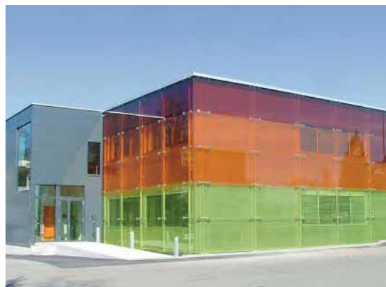
Innovative Polizei-Kommandozentrale: Kaum Problemstellen für die Vögel.
