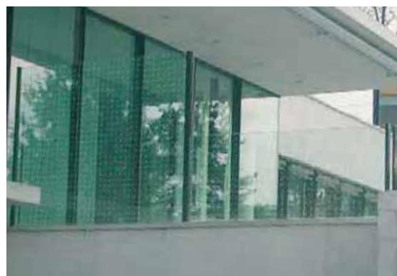
Gut gemeint, doch zu fein: An dieser Balkonverglasung mit sehr lückigem Punktraster kam es schon kurz nach der Montage zu den ersten Kollisionen.
