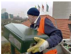
Die ersten LED-Straßenlampen werden montiert.
