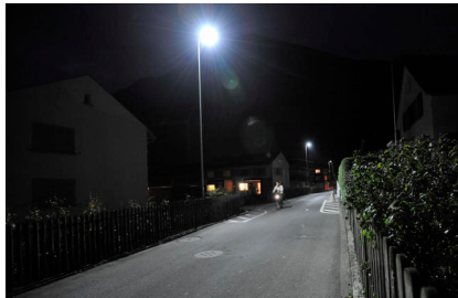
Die LED-Strassenlampen in Altdorf. (Bild pd)
