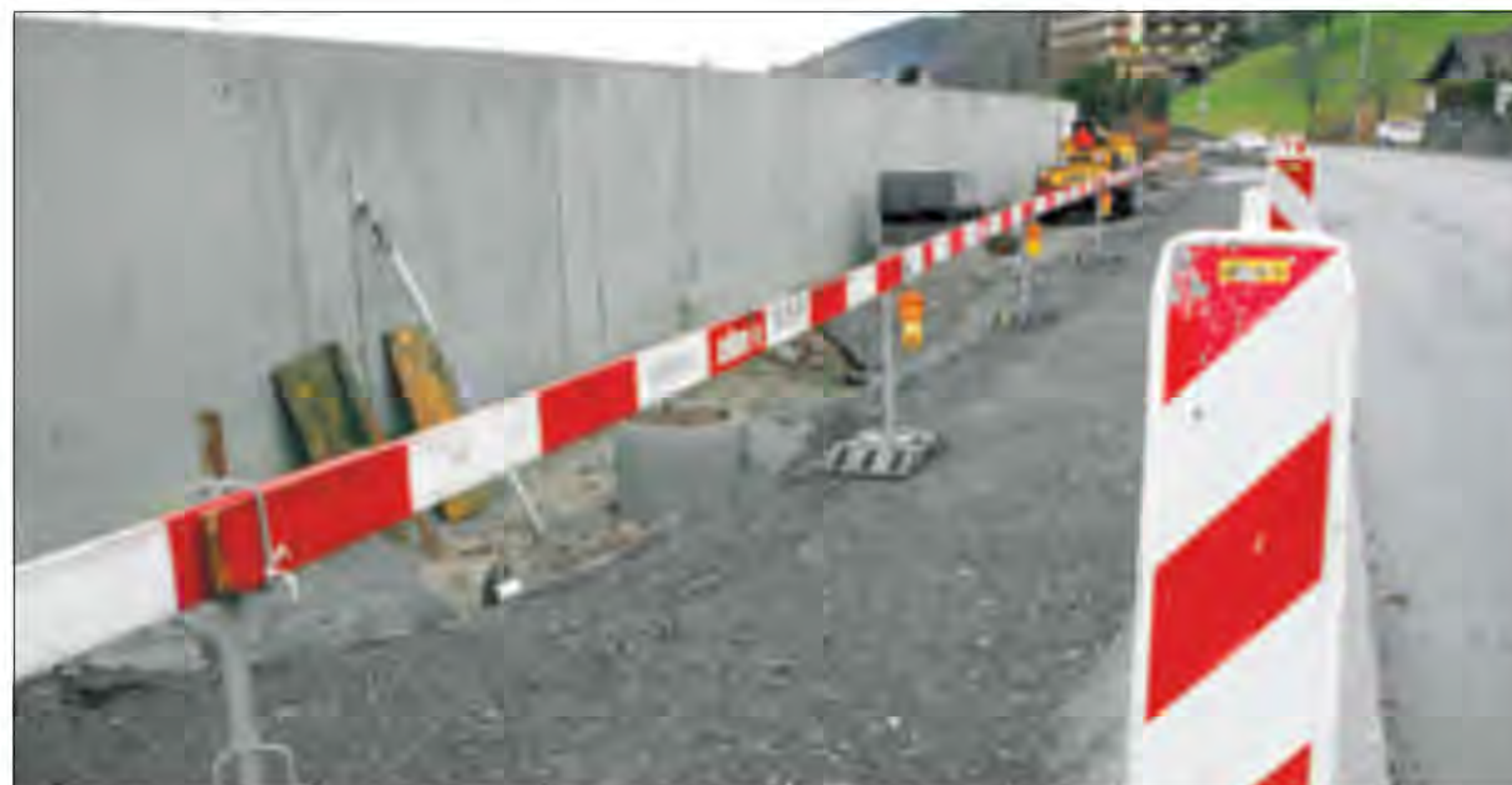
Der Streifen vor dem Bauzaun wird noch begrünt.
