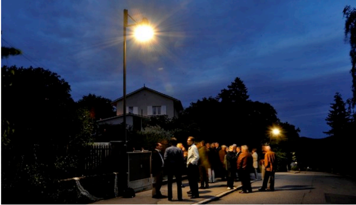
An der Hügelerstrasse in Baden sind im Mai 2010 (Foto) neue LED-Strassenlampen in Betrieb genommen worden. Archiv/EFU
