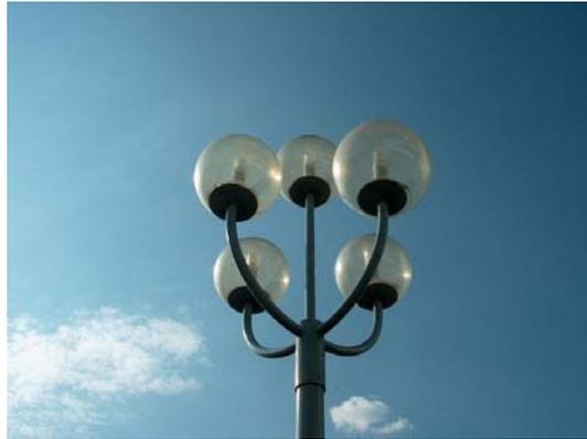
**Abbildung 9: Ausseraumleuchte ohne Abschirmung und mit hohem Lichtenergieverlustanteil**
