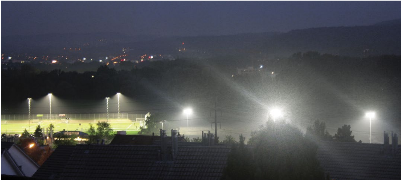
Neue Techniken für einen dunklen Nachthimmel: Sportplatz Geroldswil mit neuer (links) und alter (rechts) Beleuchtung.
