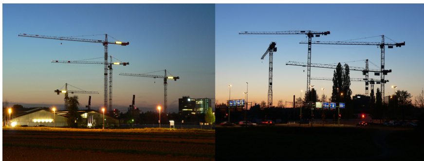
C'è chi ne approfitta (a sinistra) e nelle vicinanze le gru della EMCH AG (a destra)
