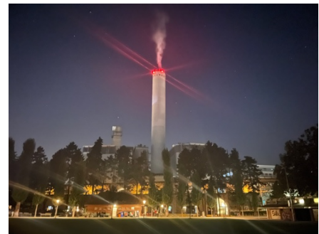
Abbildung 43: Kehrrechtsverbrennungsanlage bei der Josefwiese um 02:38 Uhr
