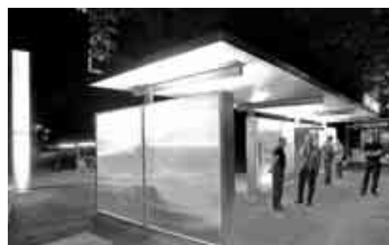
Die Lichtstelen der Regionalbahnhöfe leuchten zwar nach wie vor von unten nach oben, doch der «Lichtabfall» wurde deutlich verringert.
