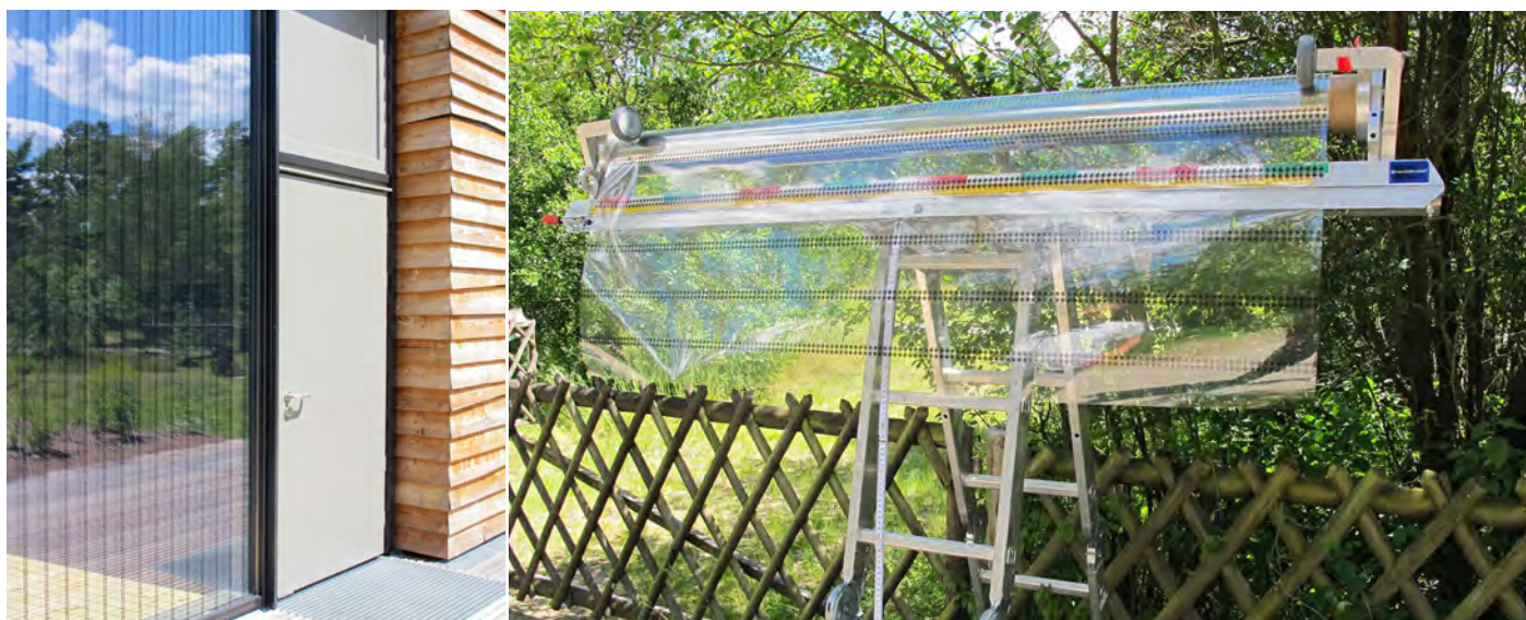
Bedruckte Folien werden vollflächig aufs Glas aufgebracht.
