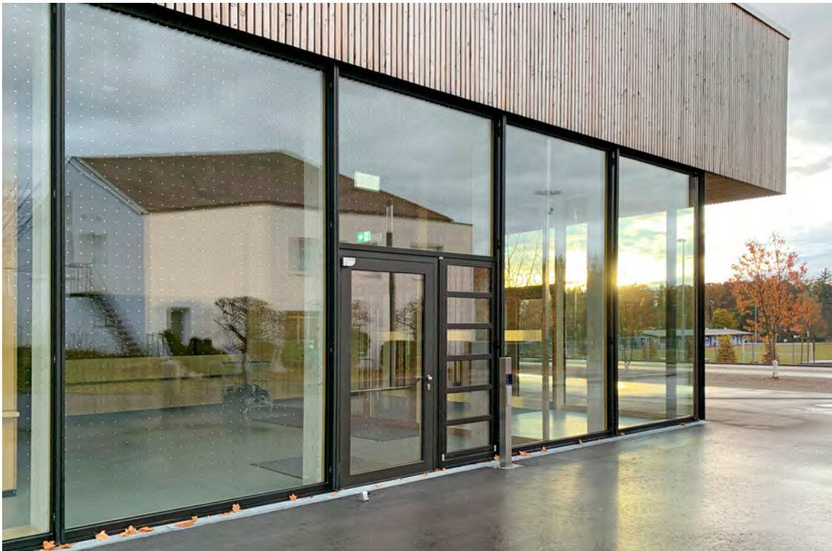
Dieses Raster aus 9 mm starken metallischen Punkten in 90 mm Abstand ist im Inneren einer Isolierglasscheibe einlaminert und dennoch hoch wirksam. Schwarze Markierungen konnten wegen Spiegelungen bisher nur auf der Aussenseite der Fassadengläser reüssieren.
