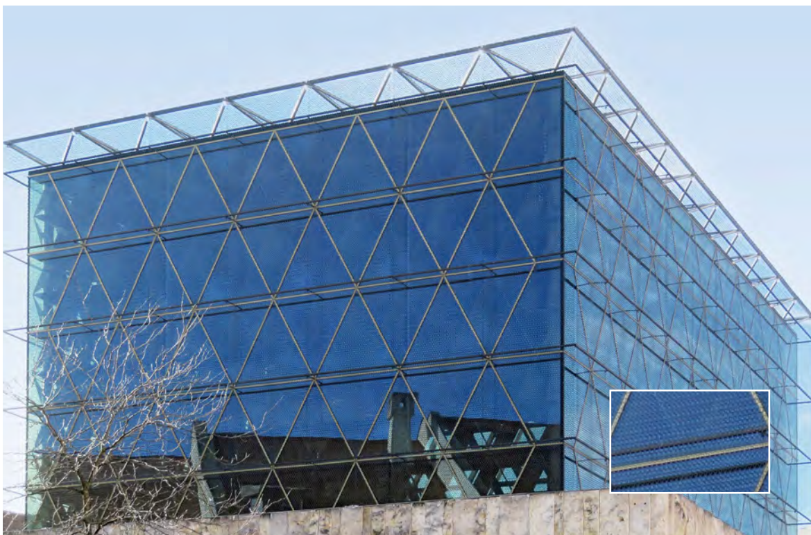
Der Glaskubus des Jüdischen Zentrums von Wandel Hoefer Lorch + Hirsch in München ist umgeben von einer stählernen Stützkonstruktion und einem Bronzegewebe. Ein Dreiecksmuster aus Davidsternen sorgt durch das Spiel von Licht und Schatten im Gebetsraum für eine besondere Atmosphäre.
