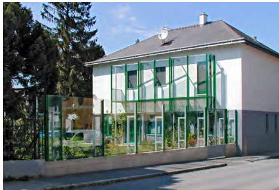
Transparente Lärmschutzwände schützen begrünte Innenhöfe und Gärten und ermöglichen ein Landschaftserlebnis entlang von Autobahnen. Sie unterbrechen jedoch die Flugbahn und fordern damit zahlreiche Opfer unter den hier lebenden Vögeln.
